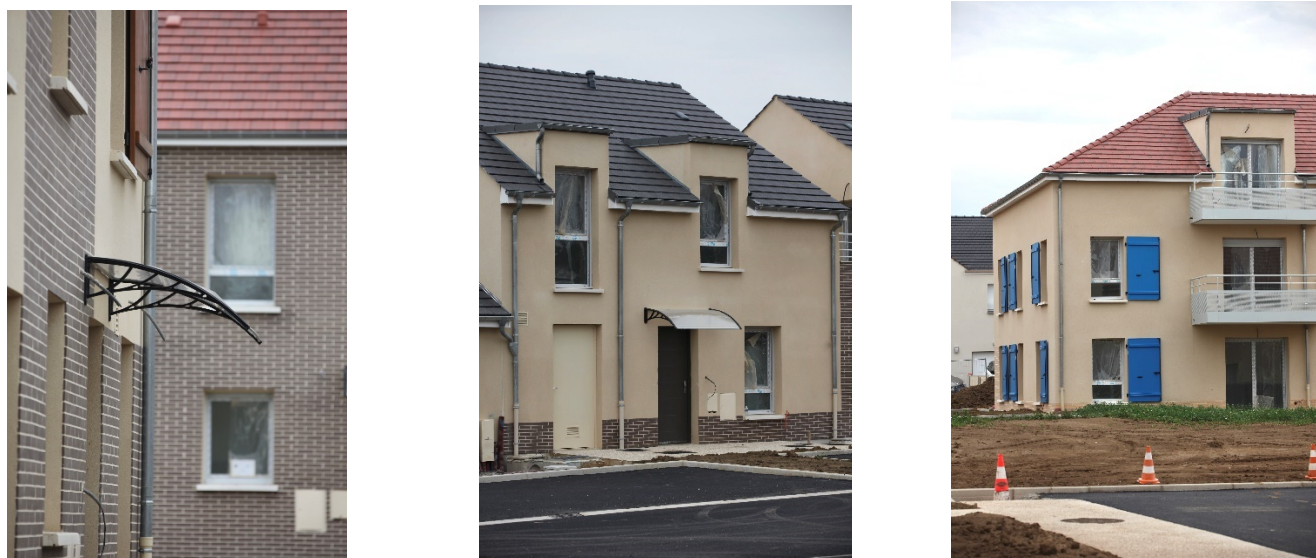
Figure 32: Photographies du projet de la Fosse Hersent en zone 1AU
