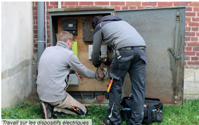
Travail sur les dispositifs électriques
